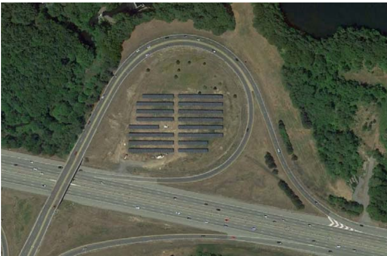
Campo solar instalado na rampa em laço da I-90 em Framingham, MA
