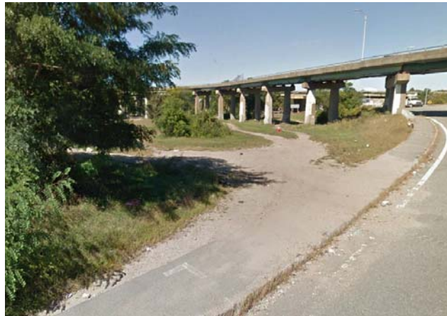
Ponto de acesso à rampa da Weld Street
