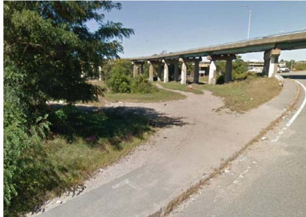
Punto de acceso a la rampa de Weld Street
