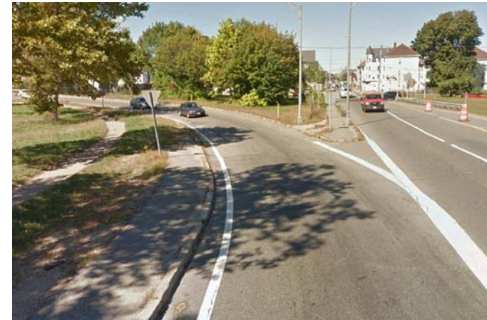
Cruce de la rampa mirando al norte
