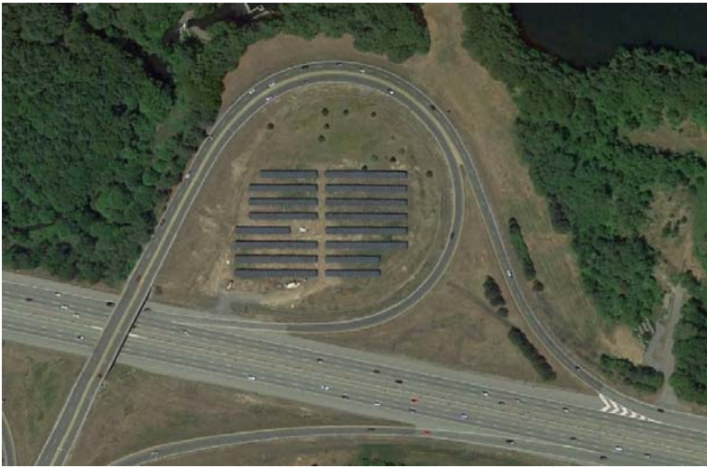
Campo solar instalado en la rampa circular de I-90 en Framingham, Massachusetts.
