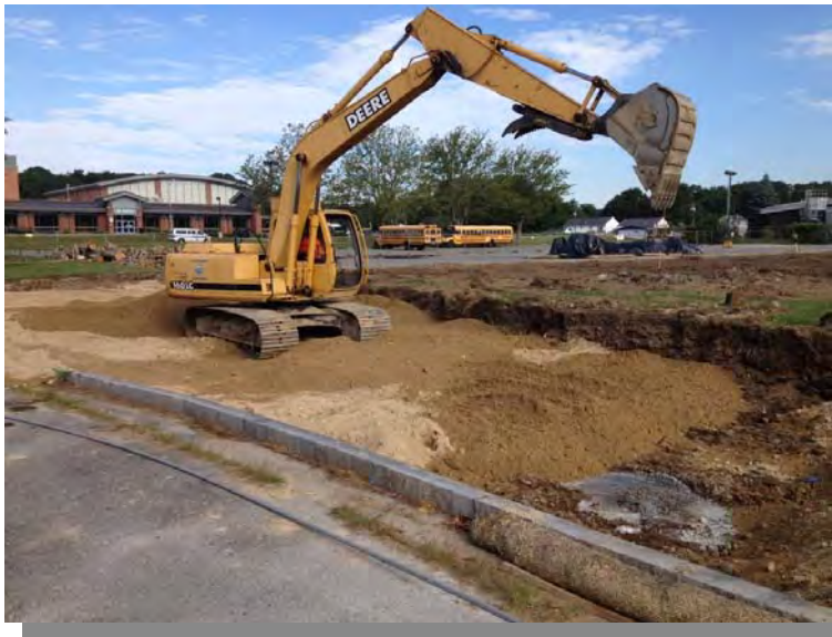
24) Backfilling of excavation (8/1/13).
