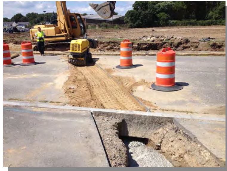
23) Backfilling of conduit trench (8/1/13).
