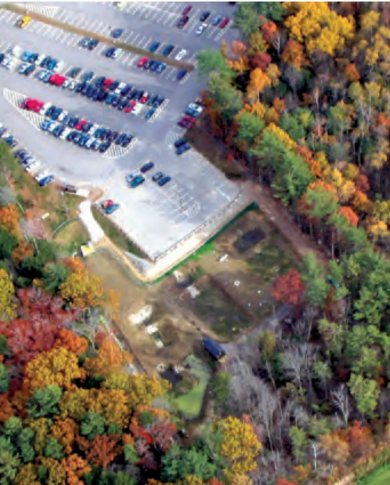
UNH Stormwater Center field site
